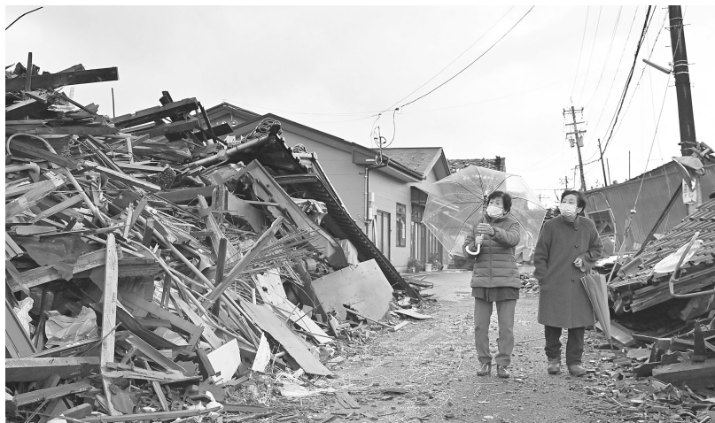
1月12日，在日本石川县珠洲市，人们经过遭地震损毁的建筑。新华社/美联
