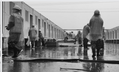
5月6日雨施,全体管理人员冒雨搬运安装方舱内设施。
