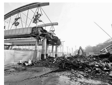
收费站拆除现场。周亚彬 摄
