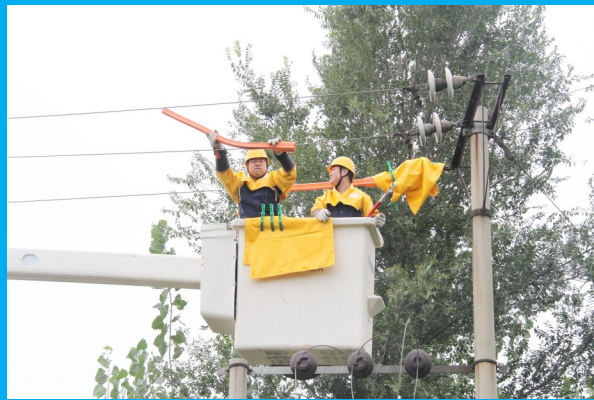
近日,国网广宗县供电公司10千伏侯寨线0734路13号杆开展带电消缺作业,确保该条线路安全稳定运行,保障用户冬季用电取暖无忧。(宋兆迪)
