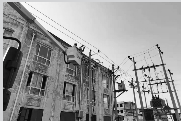
近日,国网广宗县供电公司10千伏广联线054路爱民街分支13号杆进行带电接引作业,该条线路涉及3个居民小区及2条街道商户,共计减少4个小时的停电时间,全力保障了电力用户稳定用电,提升客户电力获得感。(张志婷)
