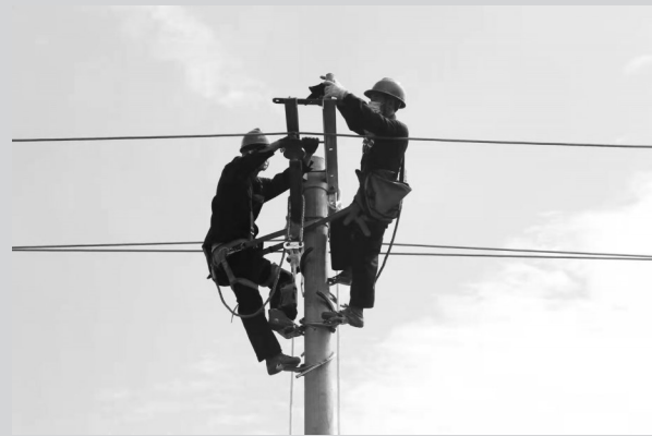
近日,国网广宗县供电公司110千伏桃园站外线路进行导线更换和电缆头接引工作,保障该站安全稳定运行,筑牢辖区稳定用电基础。(刘国栋)
