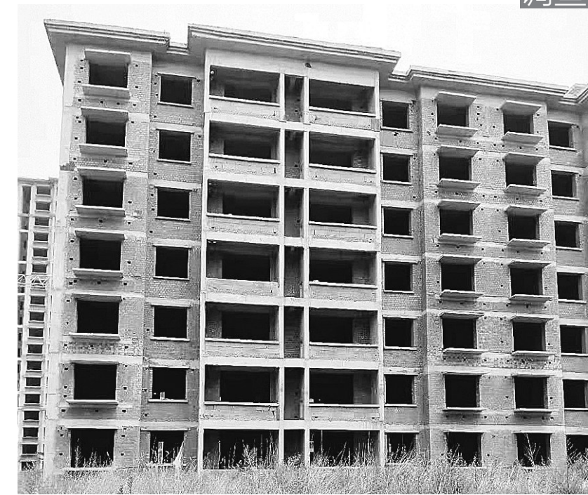
水润华府在建的7、8号楼
