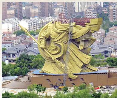
正在拆除的荆州市巨型关公雕像。
