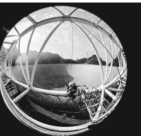
工作人员对FAST圈梁进行维护。
