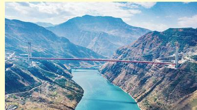
3月18日，华丽高速公路项目控制性工程金安金沙江大桥主体结构完工。大桥创下诸多世界之最：世界范围内在“三高地区”（高海拔、高落差、高地震烈度）建设的结构复杂、技术难度高、最大跨径的山区悬索桥；钢桁梁吊装设备跨径1386米，是世界桥梁领域最大跨径缆索吊；大桥宽27米，跨径1386米，宽度与跨径比达1/51，居世界第一；世界首座全桥采用U肋全熔透焊接工艺的桥梁。
