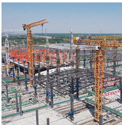
津雄场站施工现场
