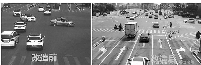
本报讯(燕都融媒体记者张辉)近日,秦皇岛交警支队对开发区长江道与泰山路交叉口进行了优化改造,改造后该路口不仅通行更为流畅,安全系数也更高。该工程由上海同济大学杨晓光教授团队专家设计,主要包括非机动车二次过街、机动车道布局优化与行驶流线匹配、信号配时优化三个方面:路口进行非机动车二次过街设计,施划二次过街等候区标线,设置非机动车隔离护栏120延长米,通过非机动车行驶流线优化与护栏隔离,彻底扭转
