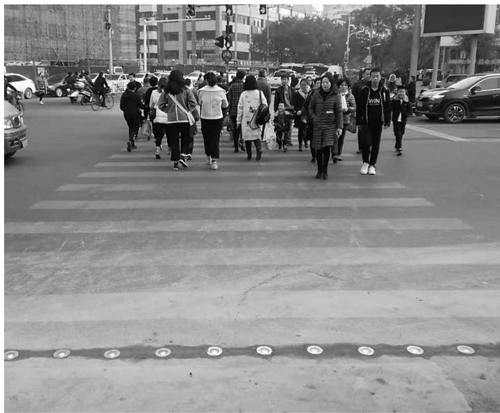
规则。而人行横道警示用LED发光装置的出现,使人行道路口的交通设施更加完善,趋于人性化,给行人从远处到近处设置了交通管制,时刻提醒行人文明出行、遵守交通规则、安全通过每个管控交通路口,对现有交通道路路口的行人起到警示的补充作用。有统计数据显示,安装人行横道
