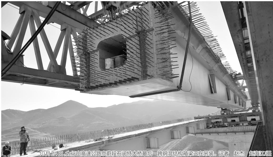
10月24日,太行山高速公路京蔚段石门特大桥最后一跨钢混结构箱梁正在吊装。记者 赵杰 赵海江/摄
