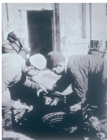
电业工人修理变压器,尽快恢复通电
