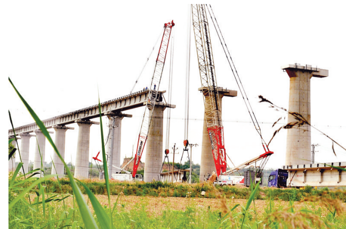
全长984.17米的和那铁路跨邢昔公路大桥
