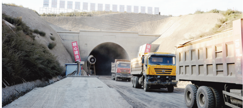
全长1388米的单洞双线隧道
