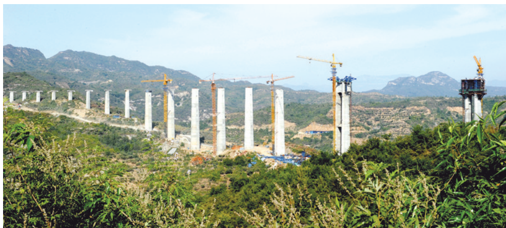
全长954米的邢台县宋家庄川特大桥
