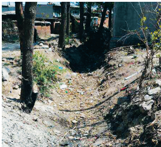
泄洪渠改造前
